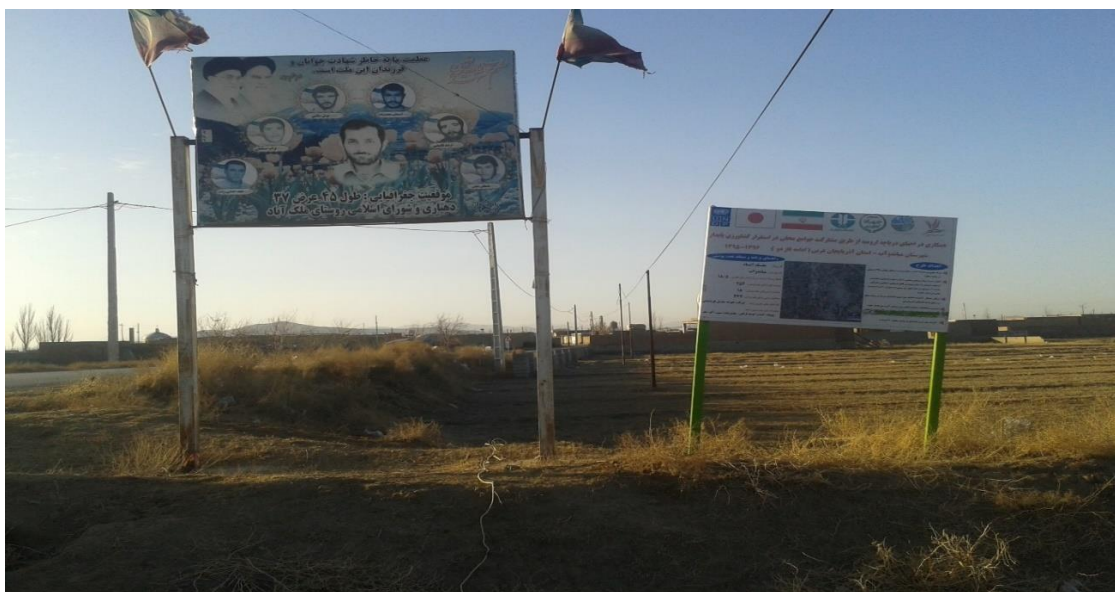
شکل ۵۱- عملیات نصب تابلو پروژه - روستای ملک آباد
