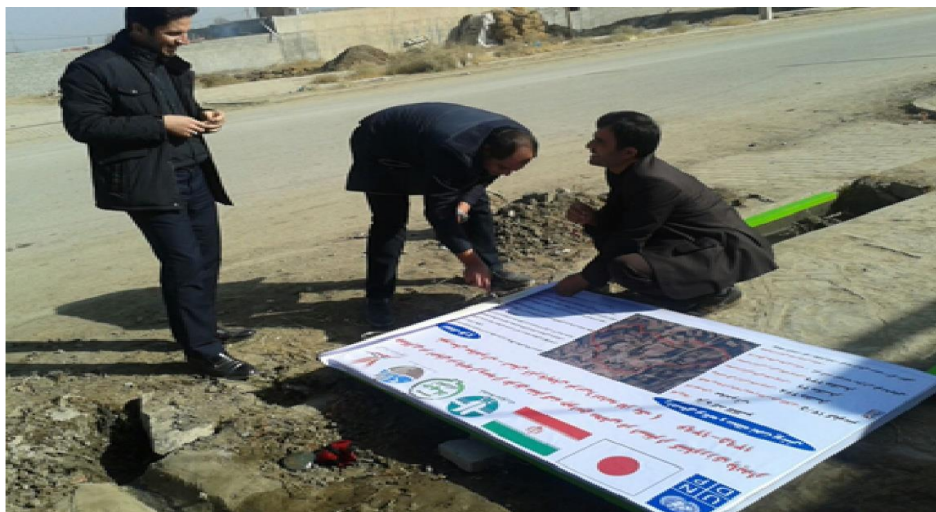
شکل ۵۰ - عملیات نصب تابلو پروژه -روستای نظام آباد
