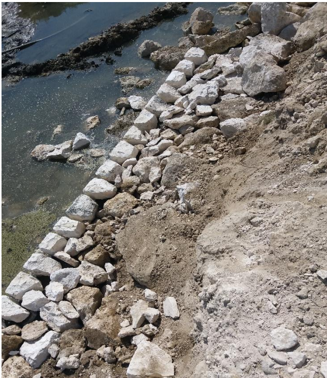
اجرای دیواره های فنداسیون و دیوارهای اصلی سازه سرریز
