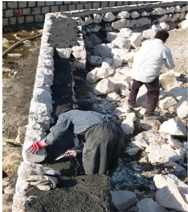
اجرای دیواره های فنداسیون و دیوارهای اصلی سازه سرریز
