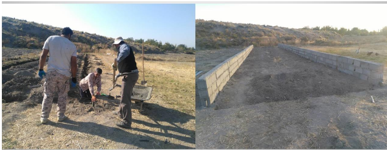
بازدید از اجرای فنداسیون و دیوار کشی ۹۹/۸/۱
