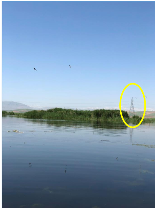
شکل ۳۲: عبور تیرهای فشار قوی برق از داخل تالاب حسنلو
