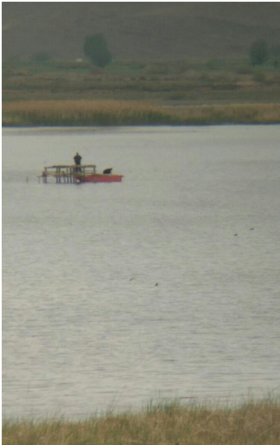
شکل شماره ۵ : تیم اجرایی پیمانکار محلی در حال ساخت پلتفرم پایش در تالاب کانی برازان
