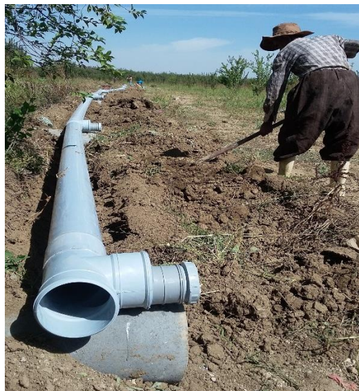
لوله گذاری برای انتقال آب
