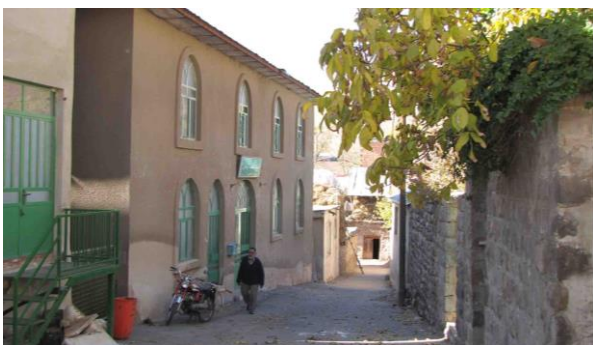
شکل شماره «۳۹»: این تصویر به روشنی تقابل استفاده از مصالح و روش‌های نوین با مصالح و روش‌های سنتی را نشان می‌دهد. دیواری که در اصالت خود سنگ چین بوده و به مرور زمان جهت رفع آسیب‌های آن از بلوک‌های سیمانی استفاده شده است. دیوارهای چینه‌ای و سنگی در مقابل دیوارهای آجری و بتنی (راست). استفاده از ملات کاهگل به عنوان عایق حرارتی در اندود دیوارهای بیرونی و دیوارهای قطور سنگی با استفاده از ملات (تصویر سمت چپ)
