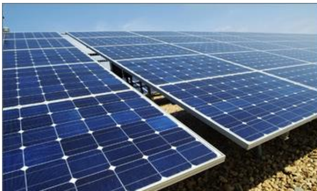
شکل شماره «۶۶»: نمونه‌ای از پنل‌های خورشیدی - هر پنل خورشیدی از تعداد زیادی سلول تشکیل شده، هر نقطه بر روی پنل معرف یک سلول خورشیدی بوده و اتصال آن‌ها به همدیگر پنل خورشیدی را تشکیل داده است.
