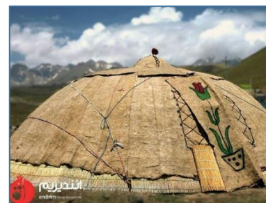
شکل شماره «۴۰»: نمونه‌ای از چادرهای ترکیبی از چوب و نی و نمد و پارچه ۸ به ترتیب از چپ به راست نحوه تکامل ساخت نشان داده شده است
