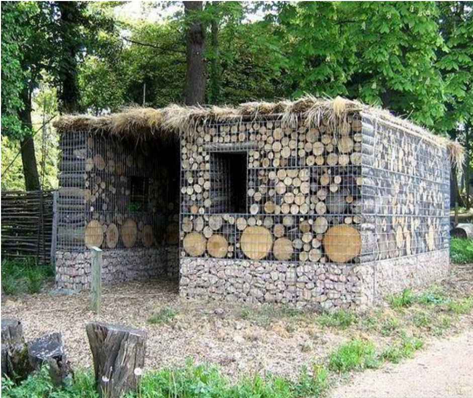
شکل شماره «۶۱»: استفاده از چوب و مش‌های فلزی به صورت همزمان در ایجاد دیوار سازه‌ای و یکپارچه - جهت قرار گرفتن چوب‌ها بر روی بازشوها به عنوان نعل درگاه متفاوت است. ابعاد متفاوت الوارهای چوبی در ایجاد یک بافت در هم تنیده و درگیر نقش مهمی ایفا کرده است. از اصطکاک سطحی بالای چوب در ایجاد پیوستگی استفاده شده است.
