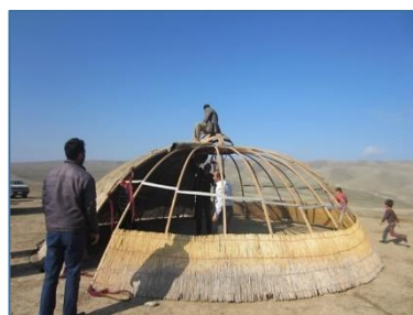
شکل شماره «۴۰»: نمونه‌ای از چادرهای ترکیبی از چوب و نی و نمد و پارچه ۸ به ترتیب از چپ به راست نحوه تکامل ساخت نشان داده شده است
