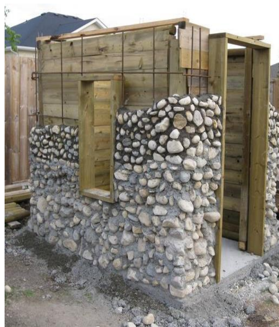
تصویر شماره «۶۴»: سنگ مالون معدنی خشکه چین بین دو لایه مش فلزی چیده شده است. سنگ‌ها بصورت تیز گوشه درگیری لازم برای ایستایی دیوار را فراهم کرده‌اند (چپ) استفاده از چیدمان سنگ رودخانه‌ای با تقویت یک لایه مش فلزی مرکزی و لایه داخلی چوبی (راست)
