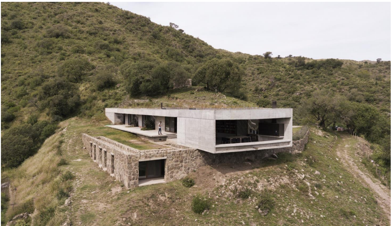
شکل شماره «۵۴»: ساختمانی ترکیبی در یک منطقه محافظت شده طبیعی -ساختمان در قسمتی اصطلاحاً زیرزمینی که با طبیعت درگیر است با سنگ ساخته شده و در قسمتی که درگیری با بستر خود ندارد با بتن ساخته شده است- بر روی تپه‌ای ناهموار ساخته شده که ناهمواری‌های آن با ساخت ساختمان سنگی برطرف شده است.
