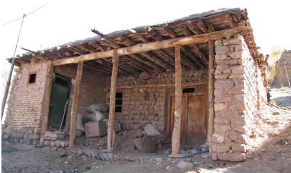
شکل شماره «۳۸»: استفاده از چوب در نرده‌های جان پناه ایوان و ستون‌های مرتفع (راست) استفاده از چوب در سقف به صورت تیرهای اصلی و فرعی و همچنین دیوارهای قطور سنگی به صورت خشکه چین (تصویر سمت چپ)
