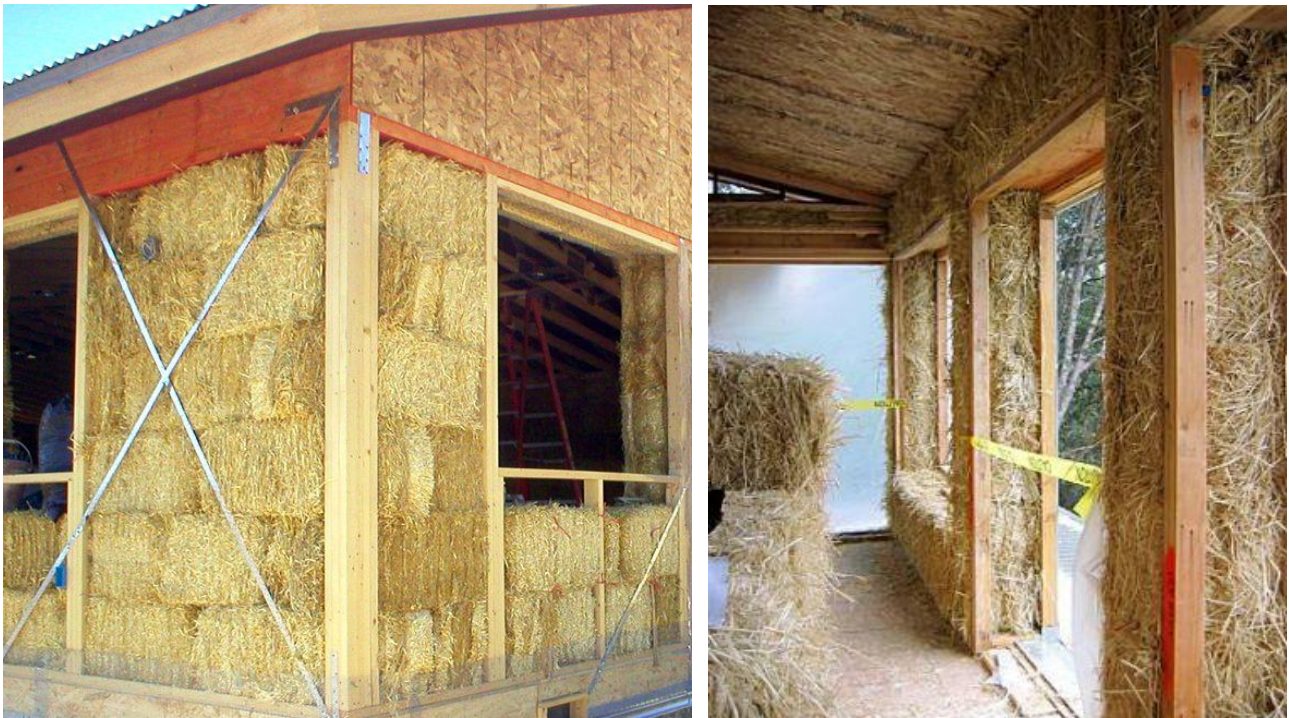
شکل شماره «۶۵»: نمونه‌هایی از دیوارهای ساخته شده با کاه فشرده که در اکثر روستاها در دسترس می‌باشد. از چوب به طور وسیع در کلاف‌های رواداری‌ها و همچنین به عنوان تیر و ستون استفاده شده است. در تصویر سمت راست از قطعات فلزی سبک برای مهار نیروهای جانبی و به عنوان بادبند استفاده شده است.
