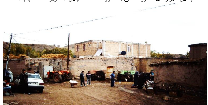
شکل شماره «۳۹»: این تصویر به روشنی تقابل استفاده از مصالح و روش‌های نوین با مصالح و روش‌های سنتی را نشان می‌دهد. دیواری که در اصالت خود سنگ چین بوده و به مرور زمان جهت رفع آسیب‌های آن از بلوک‌های سیمانی استفاده شده است. دیوارهای چینه‌ای و سنگی در مقابل دیوارهای آجری و بتنی (راست). استفاده از ملات کاهگل به عنوان عایق حرارتی در اندود دیوارهای بیرونی و دیوارهای قطور سنگی با استفاده از ملات (تصویر سمت چپ)
