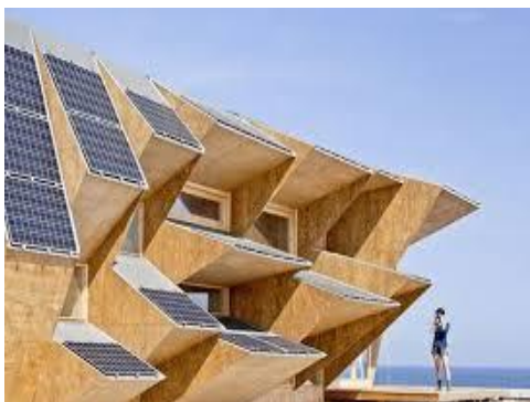
شکل شماره «۷۲»: استفاده از پنل‌های خورشیدی در ترکیبات و حجم معماری ساختمان، از محل‌های خاص در معماری برای بهره‌گیری در تولید انرژی استفاده می‌شود.
