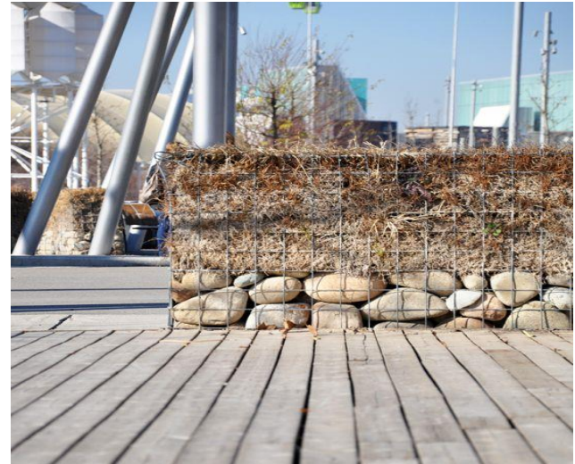
شکل شماره «۵۸»: نمونه‌هایی از فونداسیون‌های روسطحی به صورت سنگ خشکه چین برای دیوارهای چوبی (چپ) و دیوار کاه و فلزی (راست)
