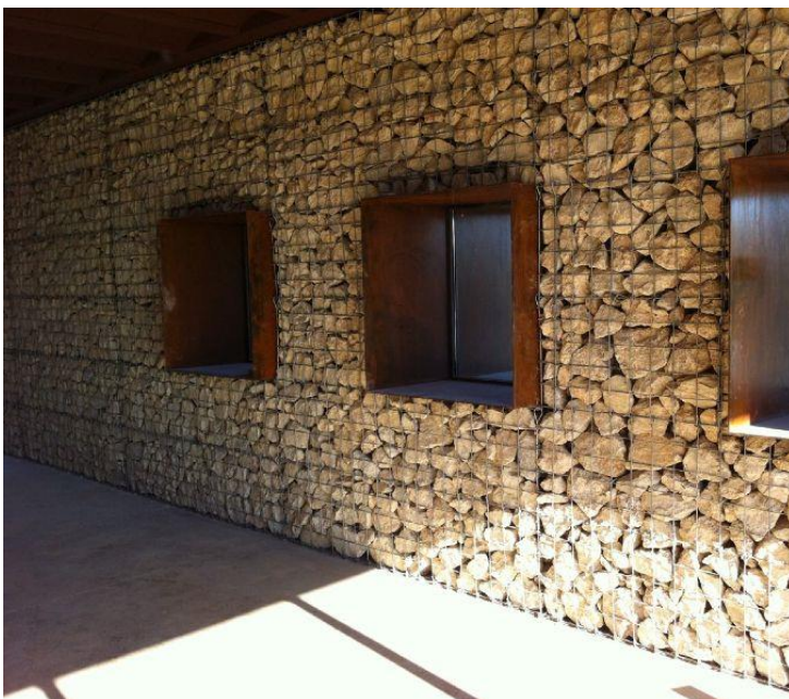
تصویر شماره «۶۴»: سنگ مالون معدنی خشکه چین بین دو لایه مش فلزی چیده شده است. سنگ‌ها بصورت تیز گوشه درگیری لازم برای ایستایی دیوار را فراهم کرده‌اند (چپ) استفاده از چیدمان سنگ رودخانه‌ای با تقویت یک لایه مش فلزی مرکزی و لایه داخلی چوبی (راست)
