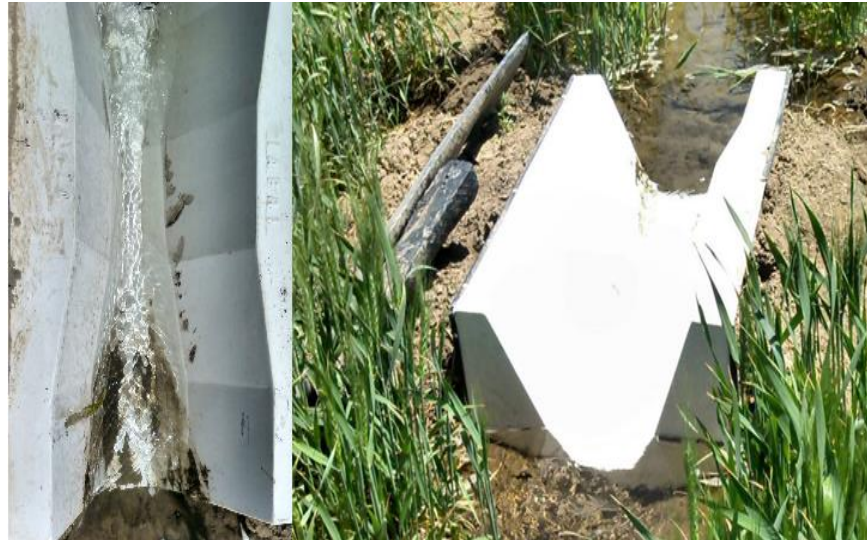
شکل ۳-۱۸- نمونه‌ای از فلوم‌های کارگذاری شده در مزارع
