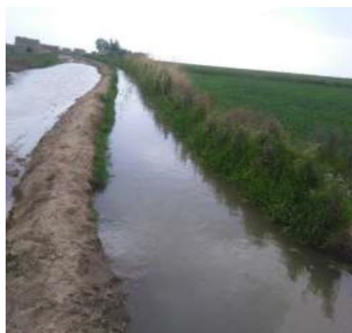
شکل ۳-۵- آبیاری مزارع گندم سایت قره‌چیق - شهرستان بناب (حجم بالای آب و عدم امکان اندازه‌گیری توسط فلوم)
